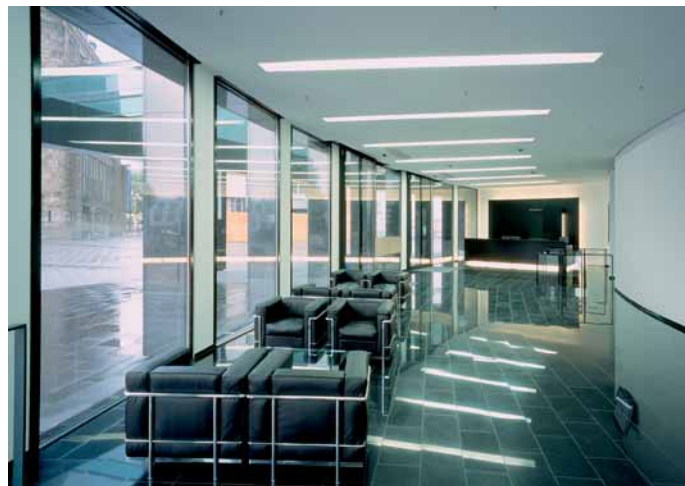
Im Foyer des Erdgeschosses wurden Basaltplatten als Bodenbeläge verwendet.
