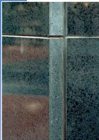
Detail der Fassadenplatten aus Basalt
