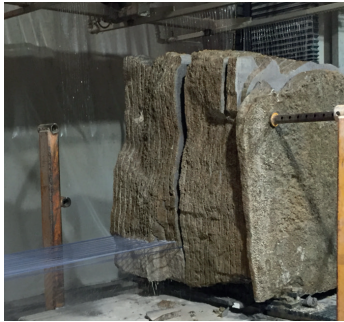
Aufgattern der Natursteinblöcke mit Multiseilsäge
