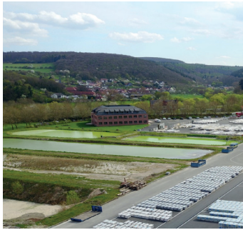
Sedimentationsbecken für Gesteinsmehl, Werk Gamburg
